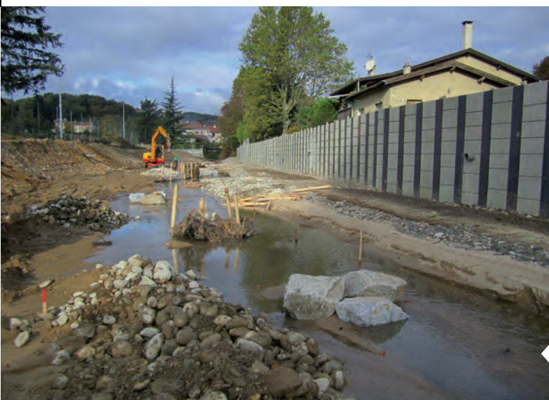
Les travaux réalisés en 2016 sur le secteur du Merlo à Oullins.
