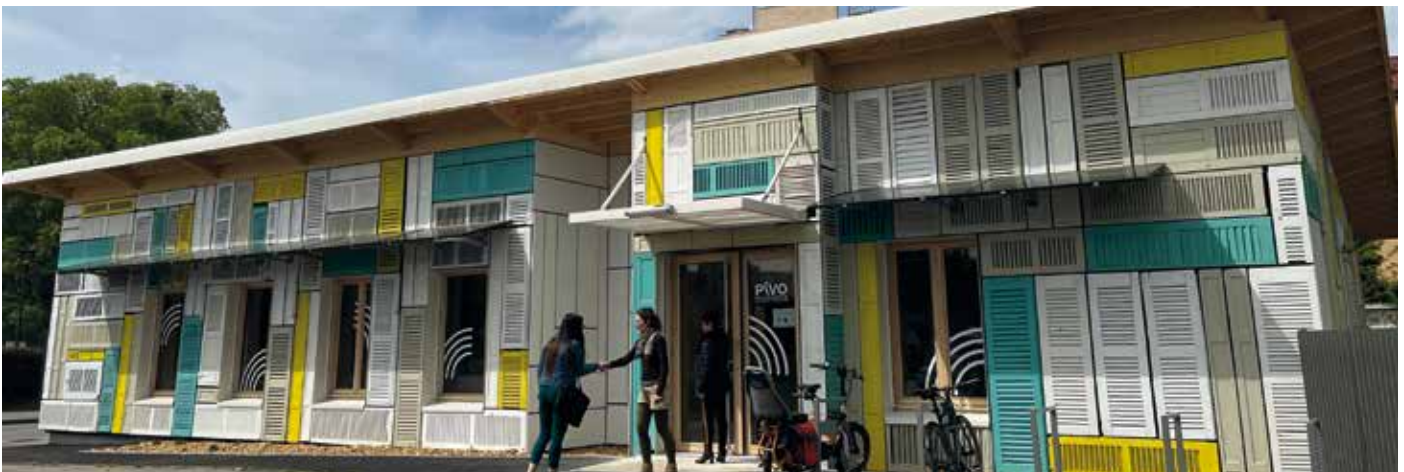
▲ PIVO - Maison du Projet de la Saulaie, bureau de l'équipe Politique de la Ville d'Oullins-Pierre-Bénite
